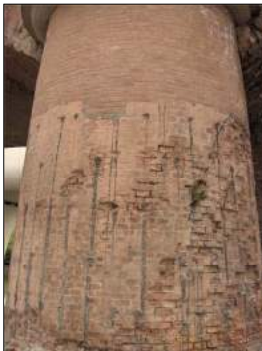
Fig. 3.16 – Particolare di una pila ove sono visibili i punti d'inserimento dei tiranti in acciaio.
