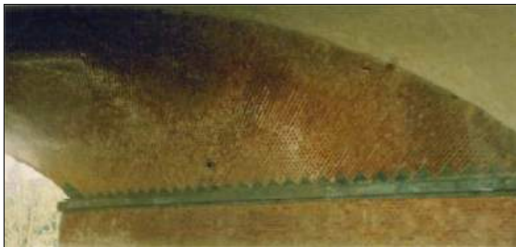
Fig. 1.26 - Tessitura elicoidale, ponte Borbore - linea Torino-Genova, progr. 54+797 (Archivio FS – TO)
