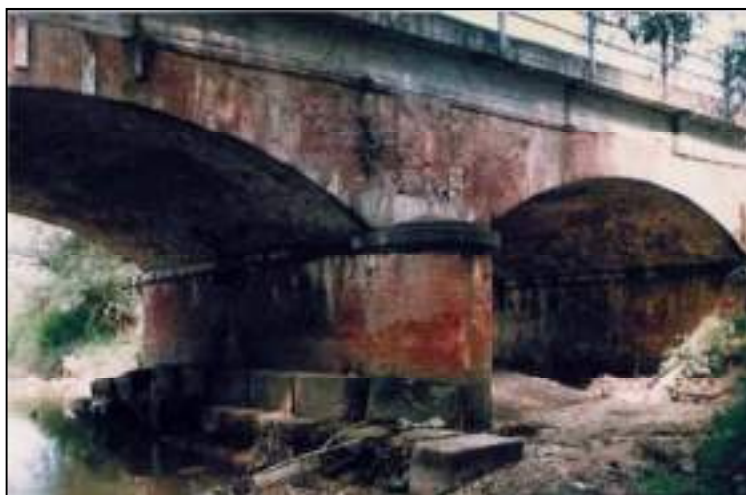
Fig. 1.3 - Pila con rostro, ponte Meletta – linea Trofarello-Cuneo, progr. 19+256 (Archivio FS-TO)
