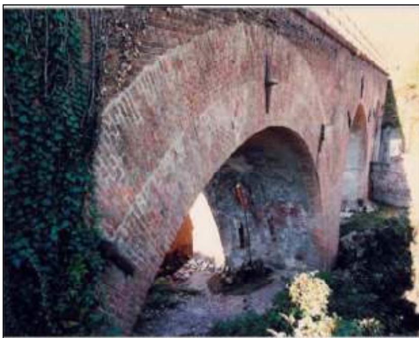
Fig. 1.28 - Arcata a due strati - linea Savona-Carmagnola, progressiva 44+477 (Archivio FS – TO)
