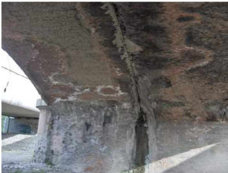
Fig. 3.9 - Particolare della soluzione di continuità presente in corrispondenza dell'ampliamento della volta
