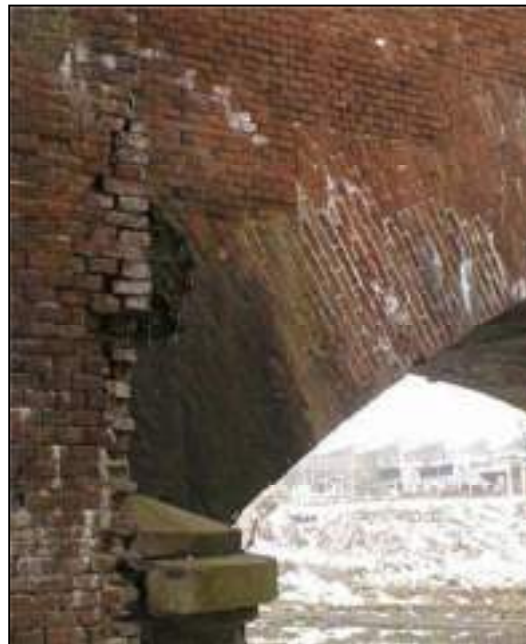
Fig. 1.25 - Estradosso dell'arcata scalettato, ponte Sangone, linea Torino-Genova (Archivio FS - TO).
