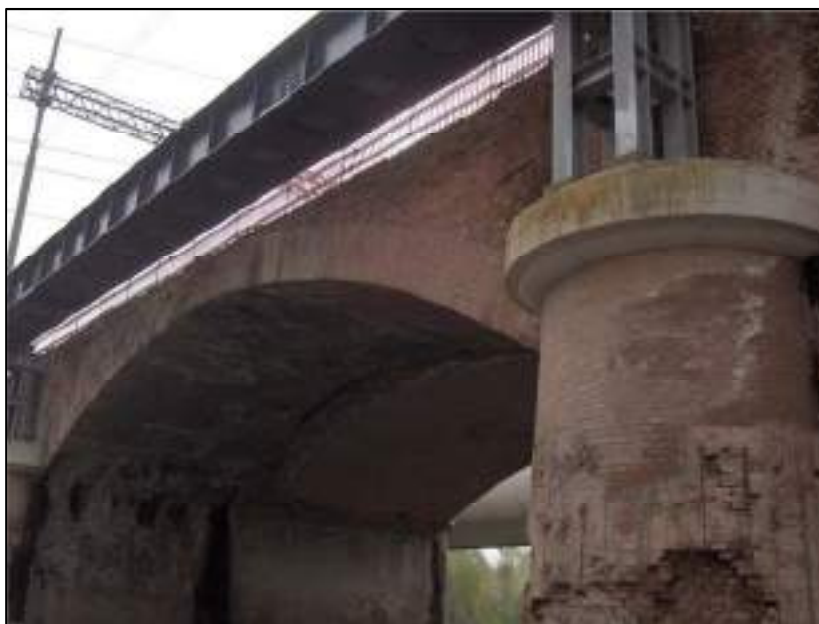
Fig. 3.17 – Particolare del timpano mancante sopra le arcate, lato a valle
