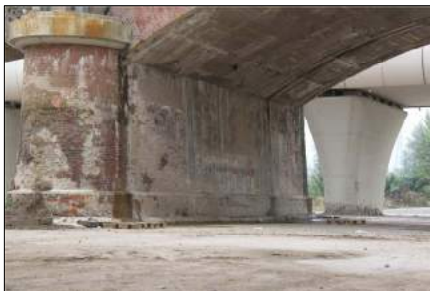
Fig. 3.24 – Vista del solettone in calcestruzzo disposto a protezione delle fondazioni
