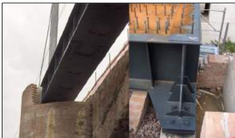
Fig. 3.14 – Particolare delle nicchie della trave a cassone, a sinistra sulla pila-spalla a destra sulla pila
