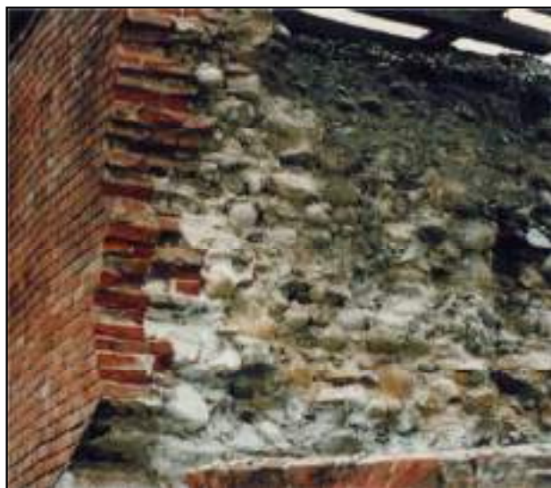
Fig. 1.32 - Particolare della sezione in prossimità dell'imposta, ponte Gesso – linea Cuneo-Mondovì (Archivio FS - TO)
