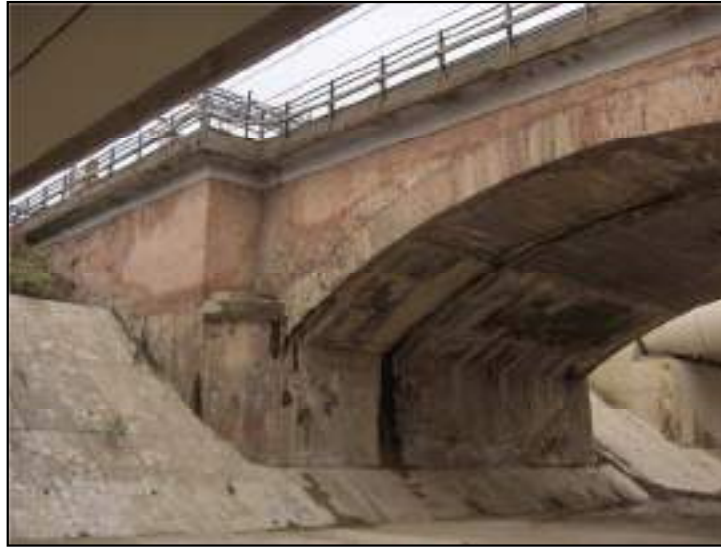
Fig. 1.20 – Spalla interrata, ponte ferroviario sul fiume Reno, Bologna
