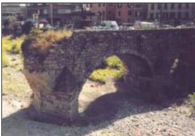
Fig. 1.4 - Posizione delle reni dell'arco strutturale (ponte di S. Agata – Genova)
