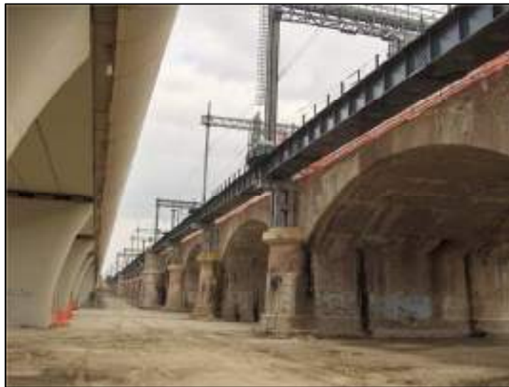
Fig. 3.11 – Ponte lato valle, vista della trave a cassone
