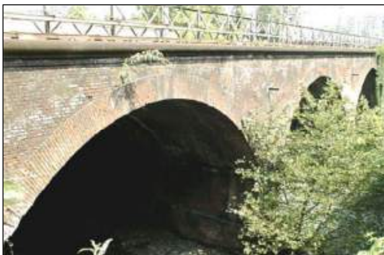
Fig. 1.12 - Muro andatorio o timpano. (ponte Dora - linea Torino-Milano, progressiva 5+915 – Archivio FS-TO)
