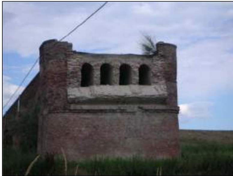
Fig. 1.31 – Rinfianco alleggerito del ponte di Bagno [Grossrubatscher, 2006]
